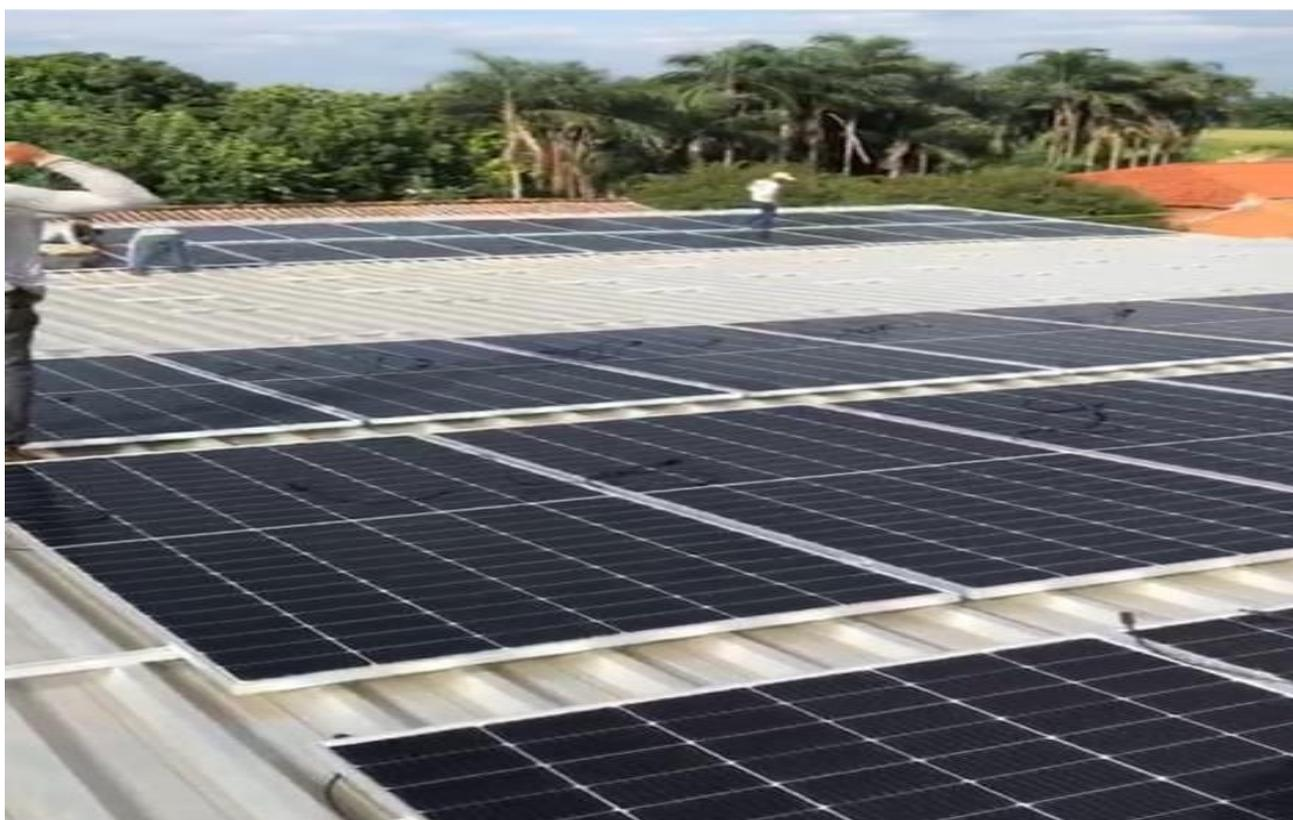
As placas foram transportadas para o telhado com um elevador de placas específico para esse fim, e as estruturas foram executadas com Hooks de fixação, trilhos, grampos intermediários e finais, da mesma forma que será executado na câmara municipal de Iracemápolis. Trata-se de um serviço de mesma técnica e com complexidade muito superior.
